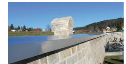
Une couverture en tôle inox assure l’étanchéité du mur
