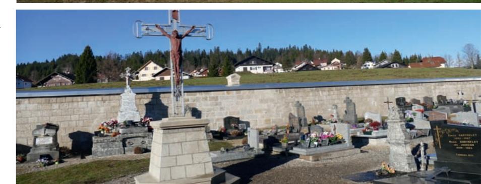
Une couverture en tôle inox assure l’étanchéité du mur
